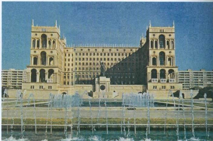
Şəkil 41. Hökumət evinin binası.
